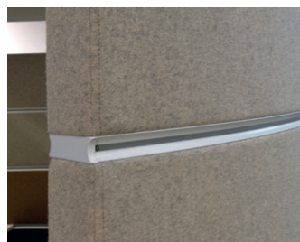
Détail d'un rail d'installation
